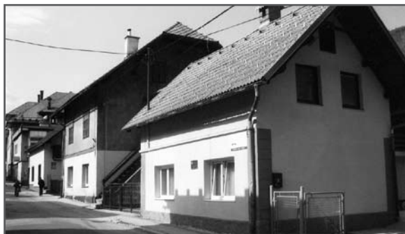
Hiša na nekdanji Obrtniški, današnji Kežarjevi ulici, kjer so v podstrešnem stanovanju živeli Trojarjevi. Last Izidorja Trojarja
