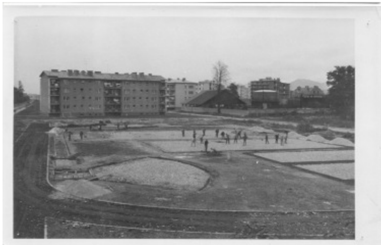
Slika 13: Začetki gradnje igrišč na I. gimnaziji v Celju
